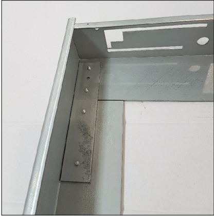
FOTO PARTICOLARE ASSEMBLAGGIO ANGOLO CON SQUADRETTA PER TUTTE LE MISURE SERIE
